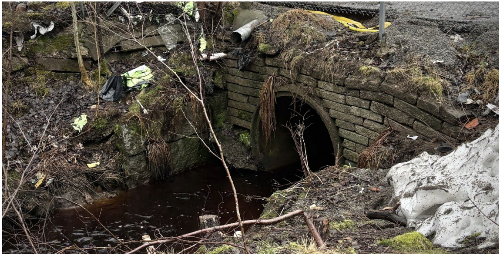
Figur 12: Inlopp kulvert under industriområde ( Trumma 3 enligt Figur 8 ).
