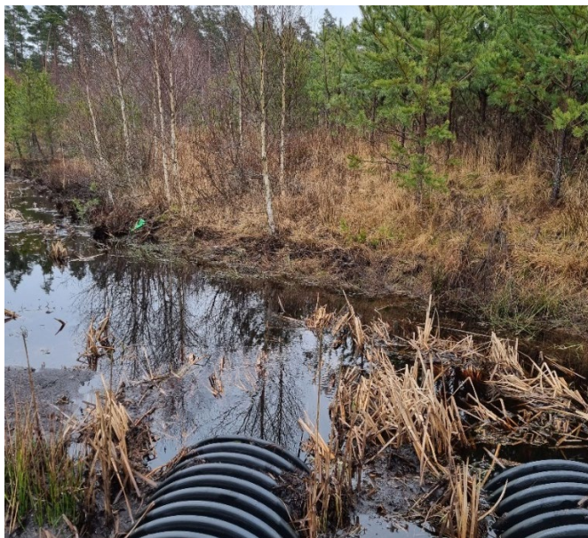
Figur 10: Utlopp, trummor efter stickspår ( Trumma 1 enligt Figur 8 ).
