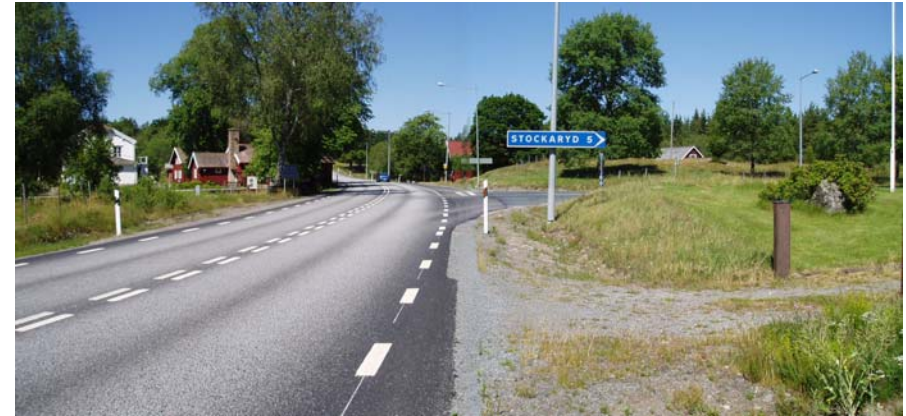
Foto 3.1.1 Nuvarande anslutning av väg 761 till väg 30 i G:a Hjälmseryd.
